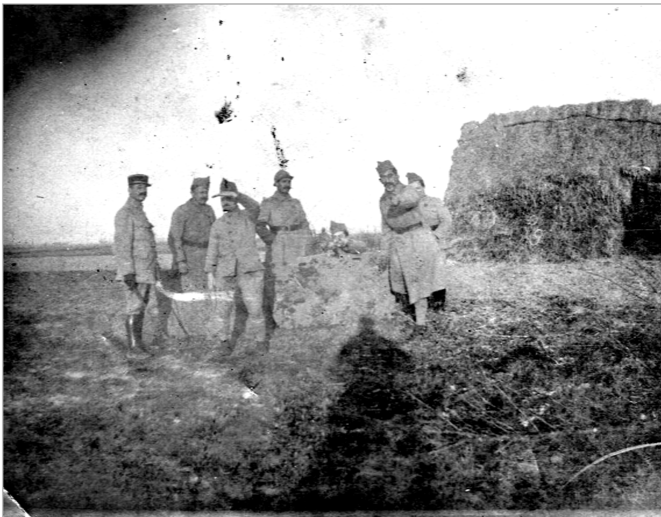
Figure 4 : « Nid de mitrailleuse sur le Steenbeeck. Contre-attaque allemande. L'ennemi s'avance en rangs serrés. La vague d'assaut est arrêtée par nos mitrailleuses et notre artillerie. (Vue prise pour le cinéma Pathé). On remarquera l'attitude calme et résolue de nos com...battants »
